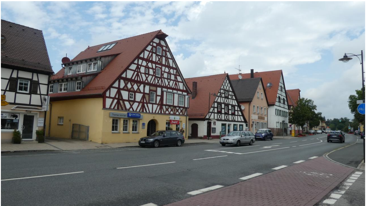
Foto 1: Ortsbildprägende Bebauung entlang der Hauptstraße (meist II oder II+D)
